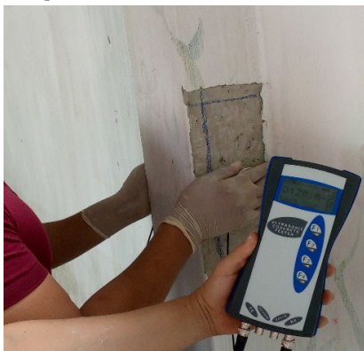
Fig. 4. Ejemplo de medición de la VPU en una de las columnas.
