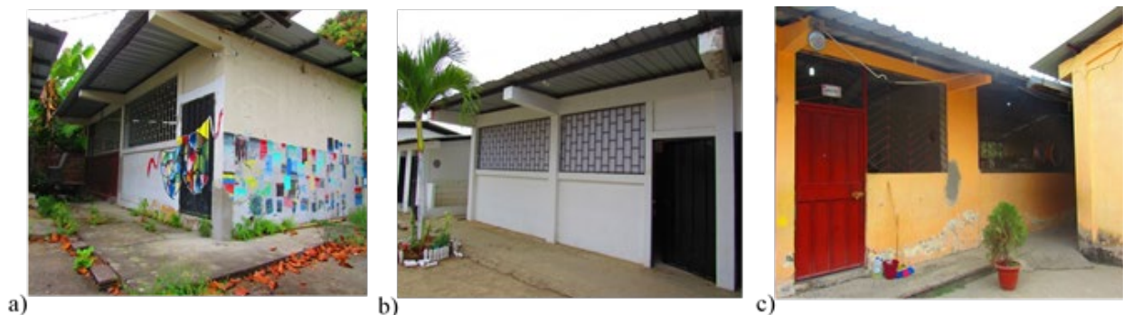
Fig. 10. Observación visual de las tres estructuras, E-1 a), E-2 b) y E-3 c).
